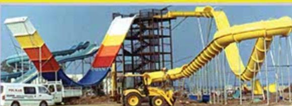
Dış yüzeyde kullanılan ve kaydırığa renk veren GELCOAT esidine ve güneş ışınlarına en üst düzeyde dayanacak kalitede, izotaktik/NPG esaslı, akıllık modifiye, tiksotropik, hızdanınca ıhtiyaç eden, yüksek performanslıdır. Su Kaydıraklarının İmalatında kullanılan POLYESTER; çekme katsayısi en düşük, esnekme katsayısi yüksek, otomatik makina için özel olarak üretilmektedir. CTP içindeki camelyef keçe oranı minimum %30'dur.
